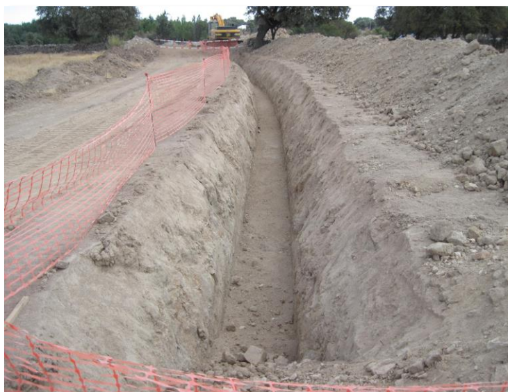
Figura 6.- Ejemplo de fondo de excavación de zanja y cama de arena
