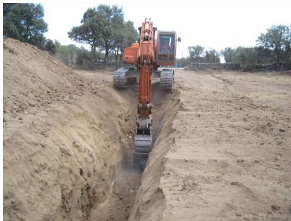
Figura 2.- Ejemplo de excavación en zanja por medios mecánicos
