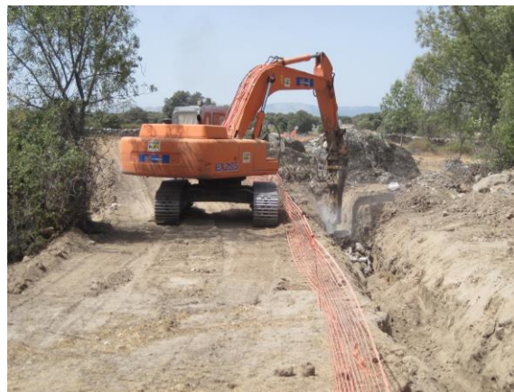
Figura 3.- Ejemplo de excavación en zanja con martillo.
