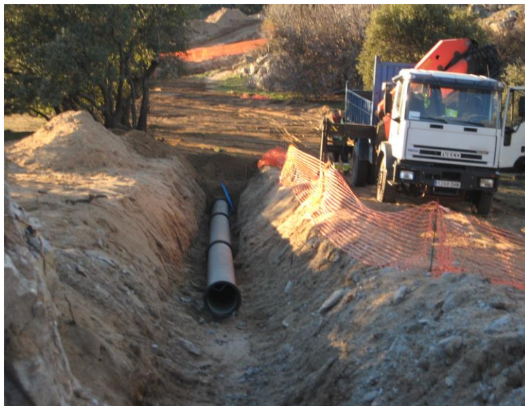
Figura 8.- Colocación de tubería en zanja.
